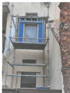
248 window framing.jpg 3778K
